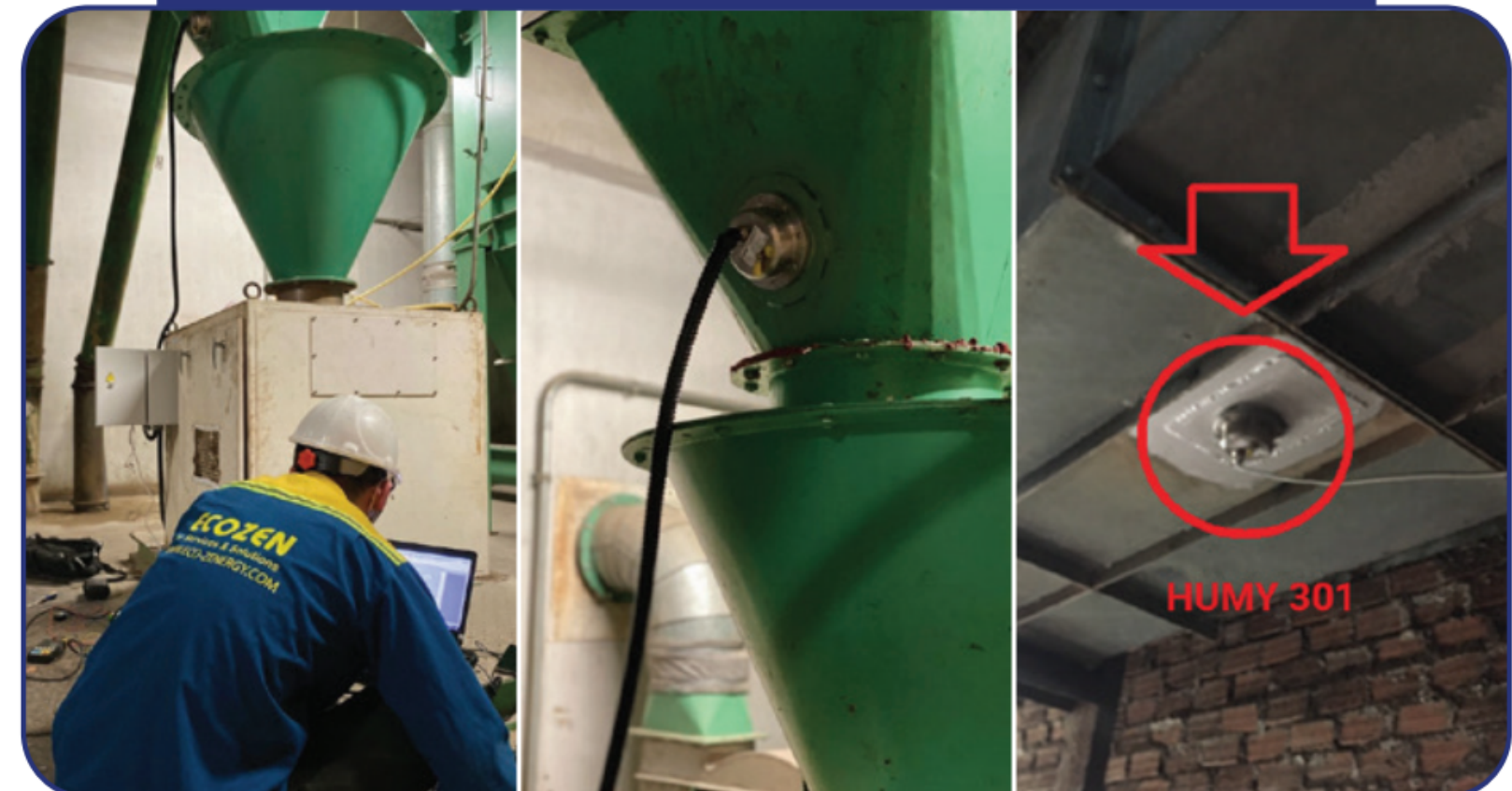
HÌNH ẢNH LẮP ĐẶT TRỰC TIẾP
